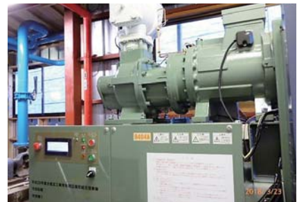
導入した冷凍機
