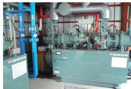
電子膨張弁制御された冷凍機設備。
