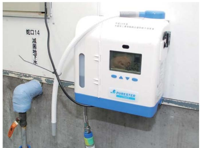
殺菌水発生装置で作られた殺菌水はすぐ使えるようにタンクに貯めている
