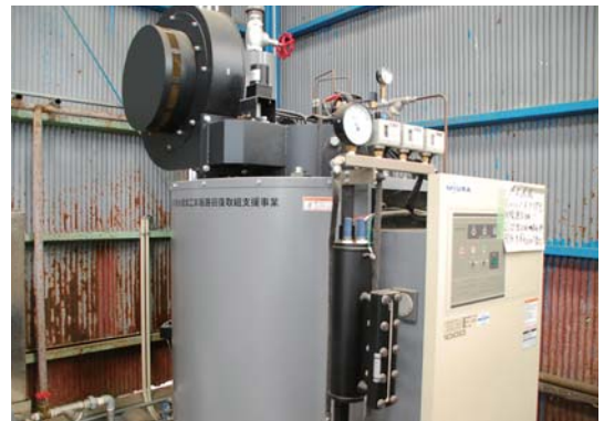
ツブ貝の漁期はフル稼働の蒸気ボイラー装置
