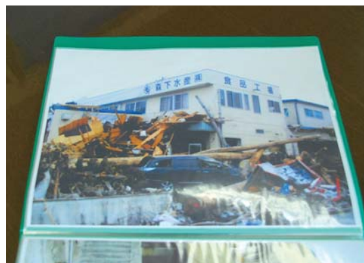
津波で全壊した森下水産の工場
