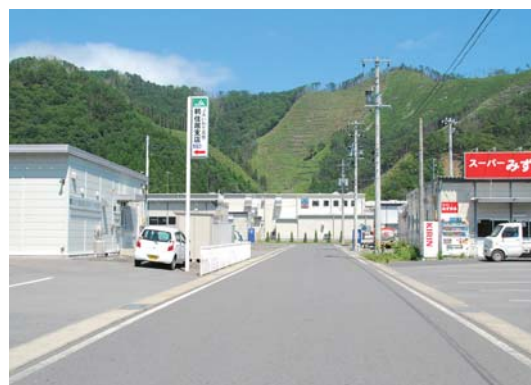
釜石市内につくられた仮設企業団地 （正面奥が津田商店の工場）
