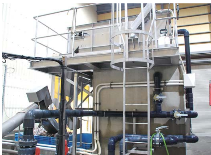
不純物を除去する排水用スクリーン
