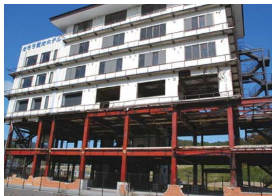
4階まで浸水した「たろう観光ホテル」は 震災遺構として保存されている
