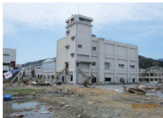
被災後の工場の様子
