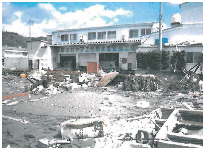
被災後の工場の様子
